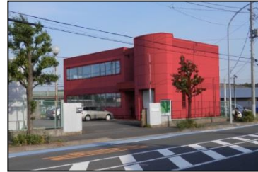
使用禁止色を使用した建物
