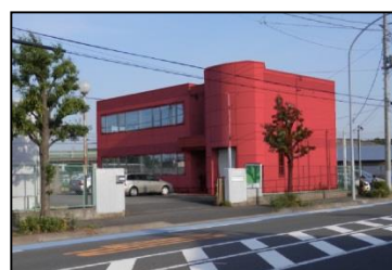
使用禁止色を使用した建物
